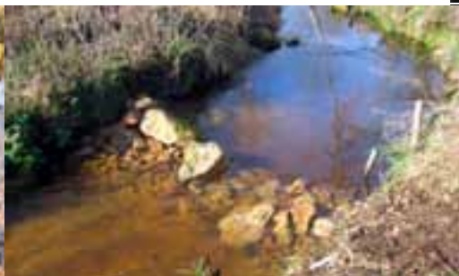
▼ La construction d'un « seuil », évolution sur dix ans.
